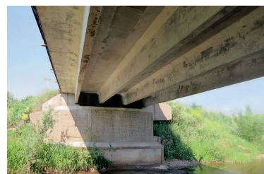
Иллюстрация 1. Общий вид автомобильного моста через р. Мулянка
